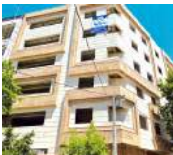
پروژه خیابان معلم
